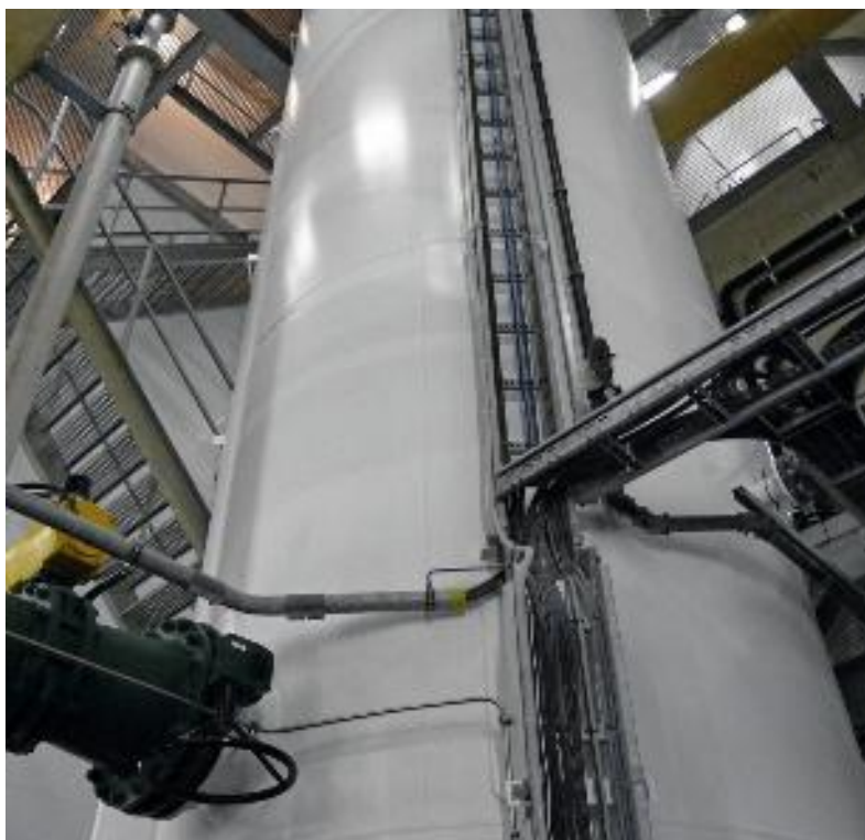
Full scale onthardingsreactor van WML (IJzeren Kuilen).
